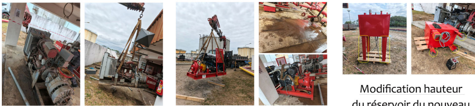
Dépose de l'ancien groupe motopompe DCI.
