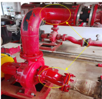
Modifications lignes d'admission/ Refoulement du nouveau groupe motopompe DCI.
