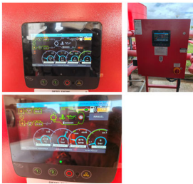
Pose, raccordement, mise sous tension, paramétrage et mise en service du nouveau groupe motopompe DCI.
